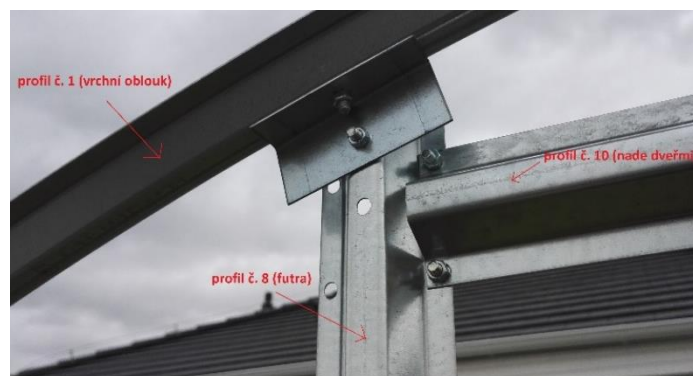
Obrázek 9.2 (foto pořízeno zevnitř skleníku)
