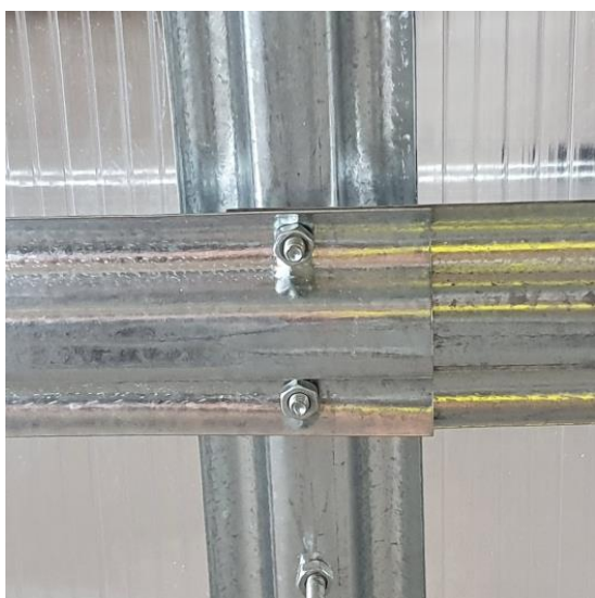
Obr. 2 - detail D (pohled zevnitř skleníku)
